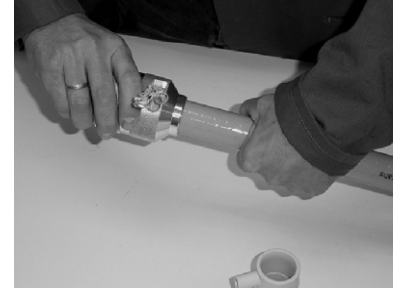
3. С трубы "Stabi" счистить алюминиевое покрытие.
