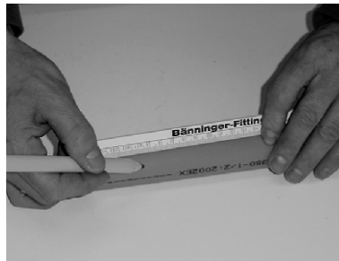
5. Отметить на трубе глубину посадки муфты.
