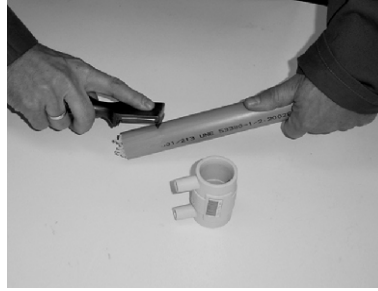
2. Наружный оксидный слой удалить с помощью щетки.
