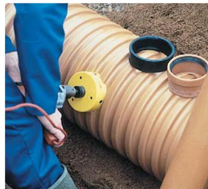
Присоединять дренажные трубы Wavin к дренажному колодцу удобнее всего по месту монтажа. Сначала торцевой фрезой соответствующего диаметра вырезается отверстие в гофротрубе колодца.
