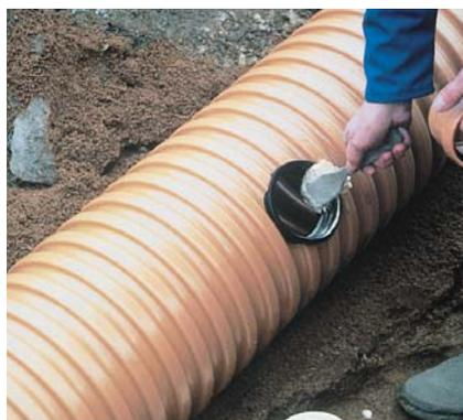
На внутреннюю поверхность уплотнения наносится силиконовая смазка, после чего вставляется пластиковая муфта перехода «In Situ».
