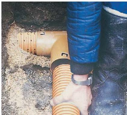
Для выполнения отвода от существующей дренажной трубы откопайте нужный участок и вырежьте участок трубы обычным ножом. Удалите обрезки и установите тройник.
