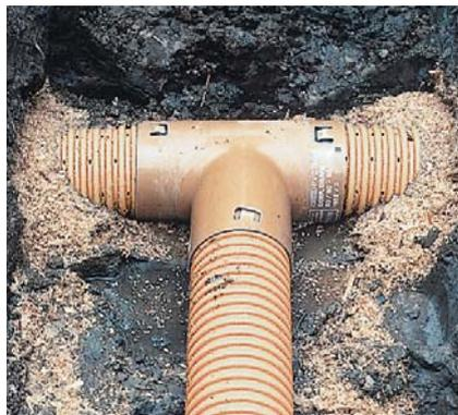
Присоедините трубу, вставив ее в тройник до полной фиксации.
